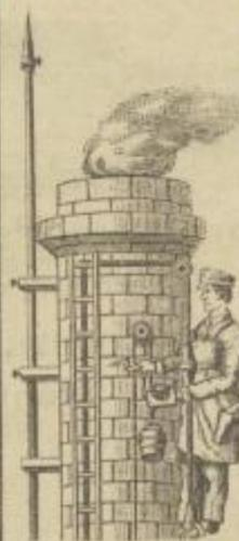
Neubau, Lieferung der Formsteine, Reparaturen jeder Art während des Betriebes (Höherführen, Geraderichten, Ausfugen, Binden, Anbringen der Blitzableiter, Theeren eiserner Schornsteine) mit Steigeapparat (D. R.-Patent).
