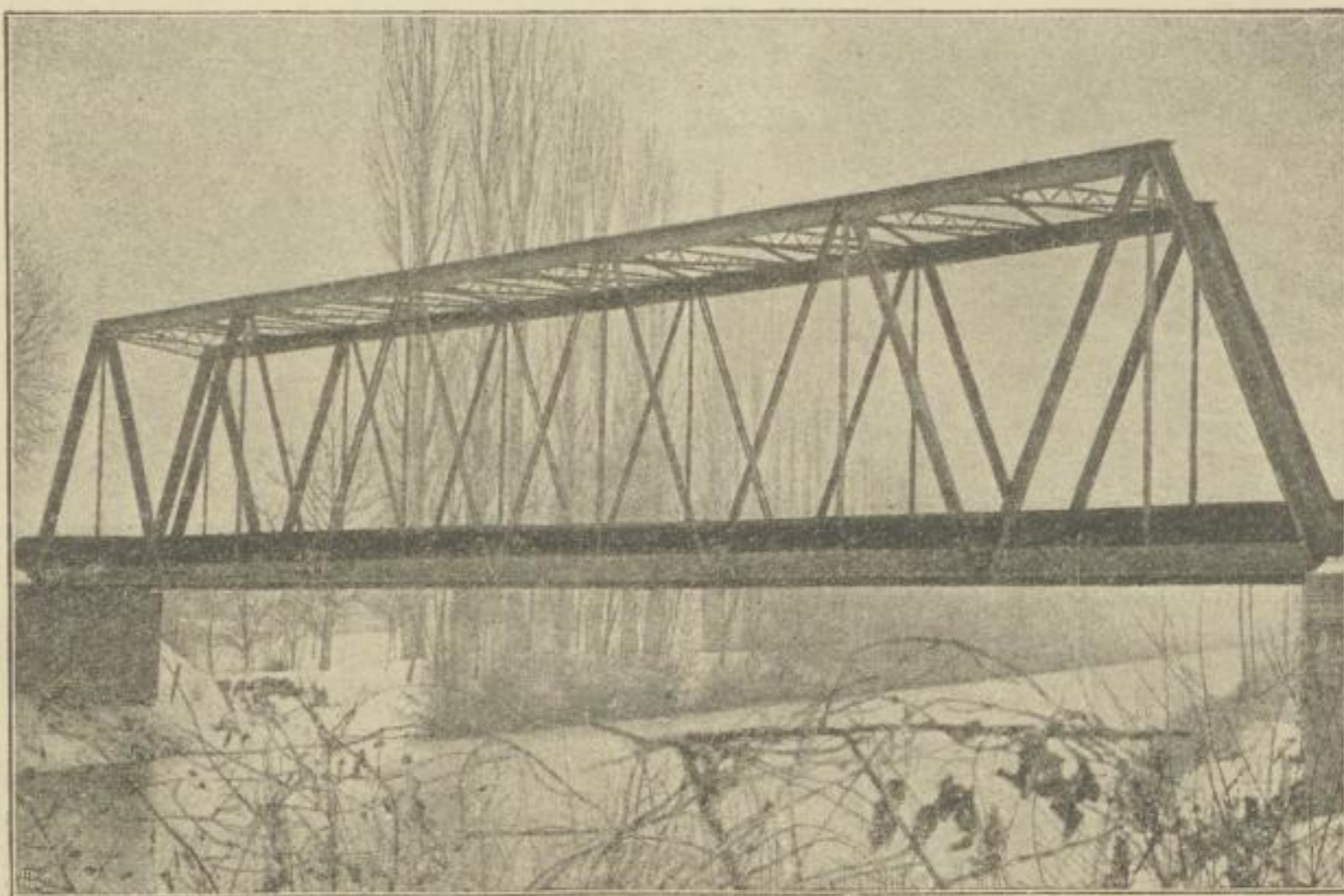
Abbildung 4. Die Brücke vor dem Einsturz.
