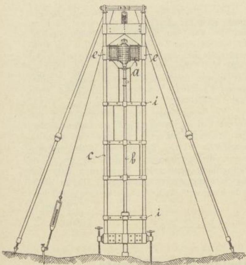
lastet, der Vorschub des Bohrers also unter dem Gewicht des Elektromotors *a* und Gestänges *b* erfolgt. Um ein Schlagen des Gestänges zu vermeiden, ist dasselbe in den auf dem Gestell verschiebbaren Sprossen *i* geführt.
