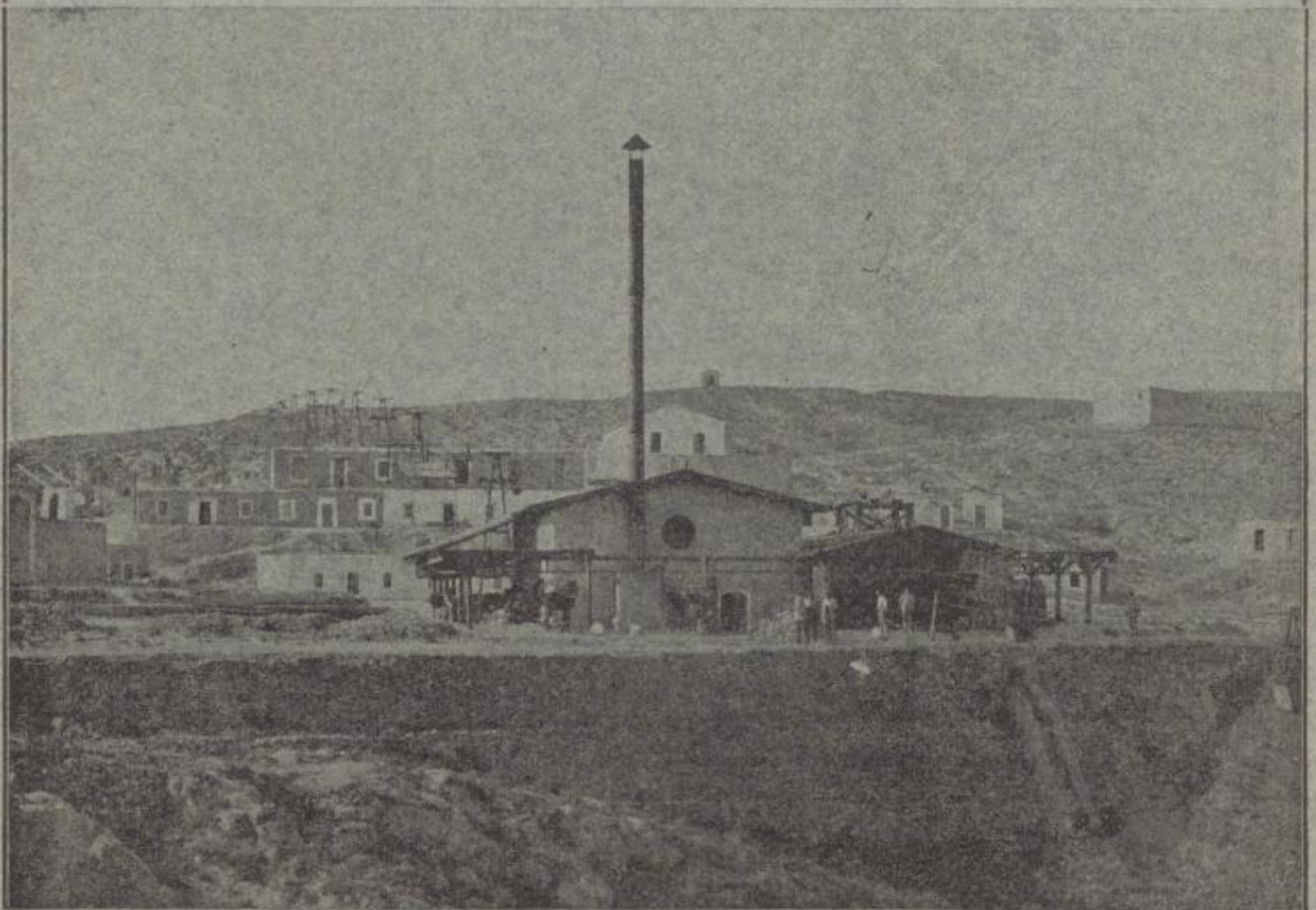
Erste Maschinenstation der 15,6 Km. langen Drahtseilbahn Bedar-Garrucha (Südspanien).
