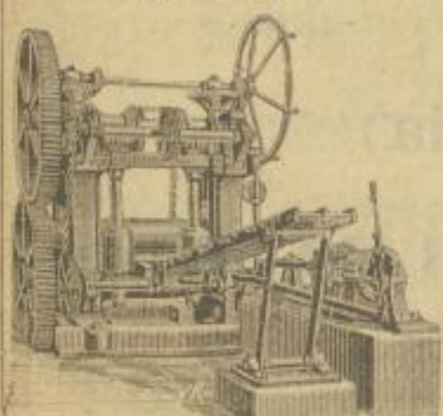
WALZWERKSMASCHINEN Converter. Gebläsemaschinen.
