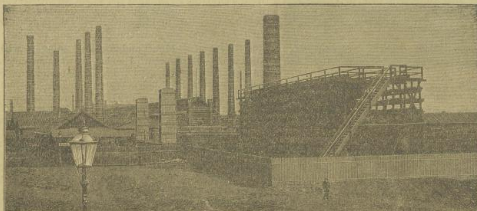
Fig. 1. Gradirwerk einer grösseren Centralcondensation, für 6—8 cbm. minutlicher Kühlwassermenge oder 320 kg zu condensirenden Dampf, entsprechend 2000 Compoundmaschinen-Pferdestärken.
