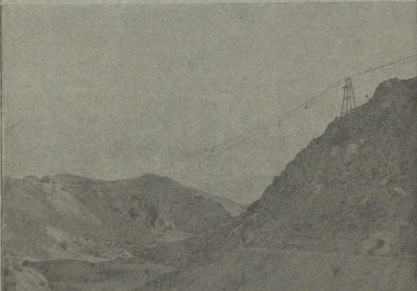
Spannweite von 200 Meter der 10,6 km. langen Drahtseilbahn Bedar-Garrucha (Südspanien).
