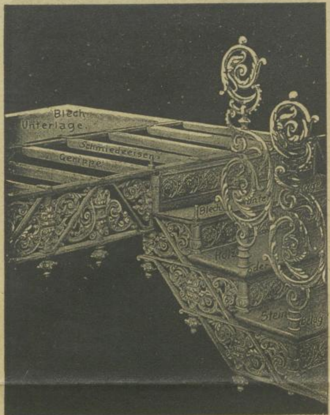
Fig. 72. Treppe und Podest in Ausführung begriffen.
