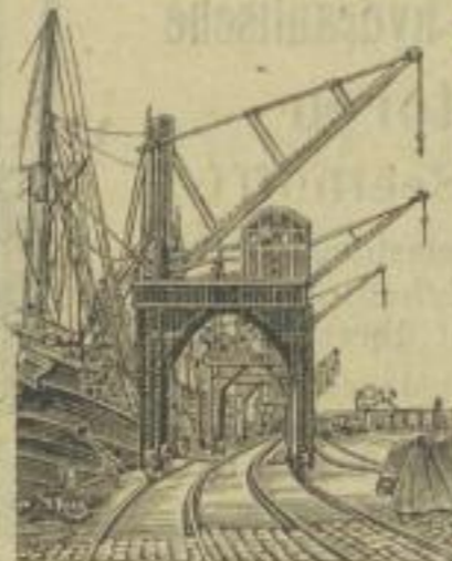
INSTALLATIONEN I. SEEHÄFEN Hydraulische Krähne und Accumulatoren. Druckpumpen etc.
