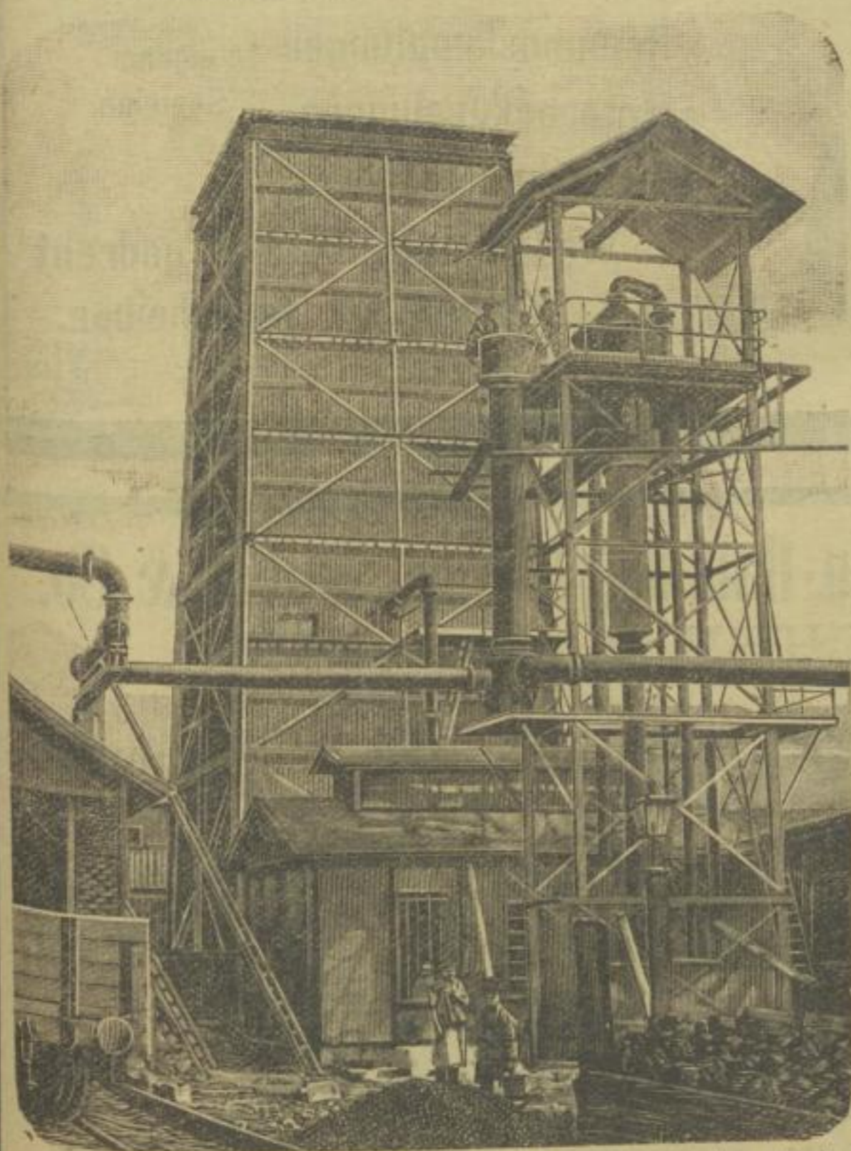
Kamin-Kühlwerk, Patent Zschocke, Leistung 180 cbm stündl., ausgeführt für Gufsstahlfabrik Fried. Krupp, Essen.
