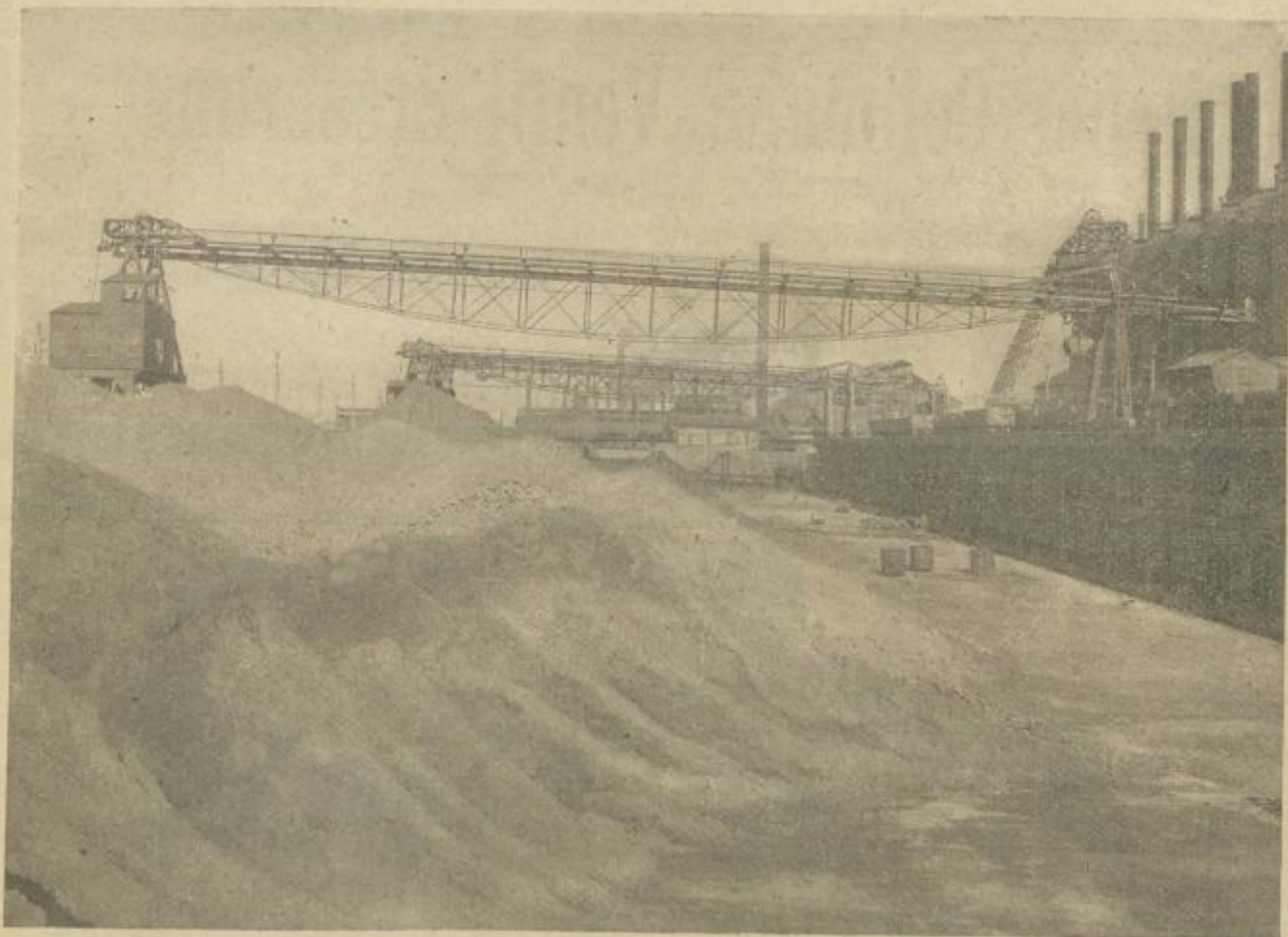
5 Tonnen-Erzverladekrahne der Carnegie Steel Works in Duquesne, Pa.
