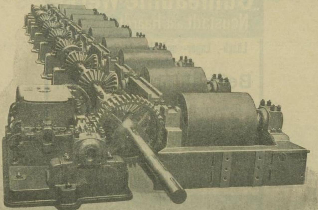
Transportrollgang mit direktem elektrischen Antrieb.
