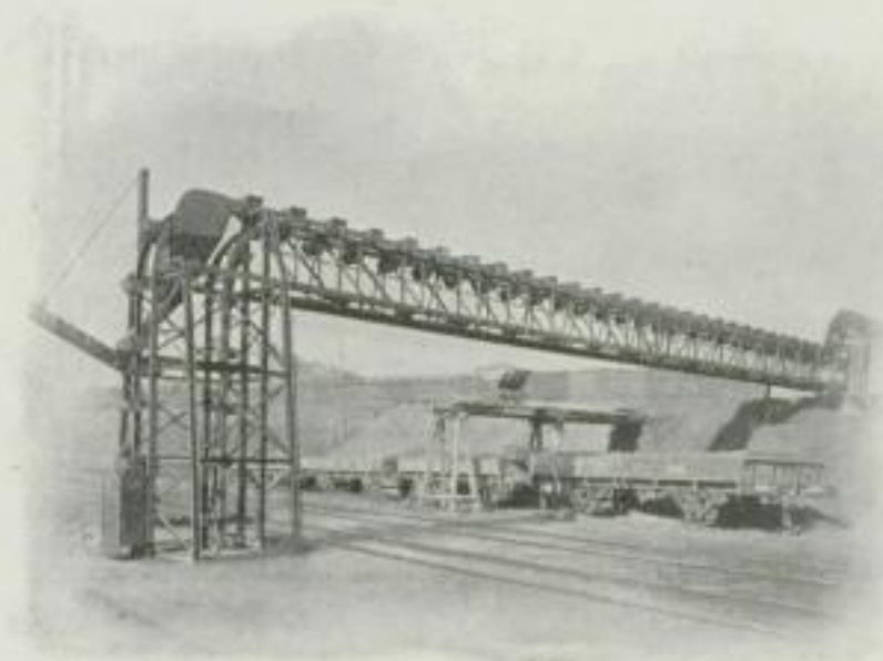
Conveyor-Anlage, ausgeführt für die Kgl. Eisenbahndirektion St. Johann-Saarbrücken.
