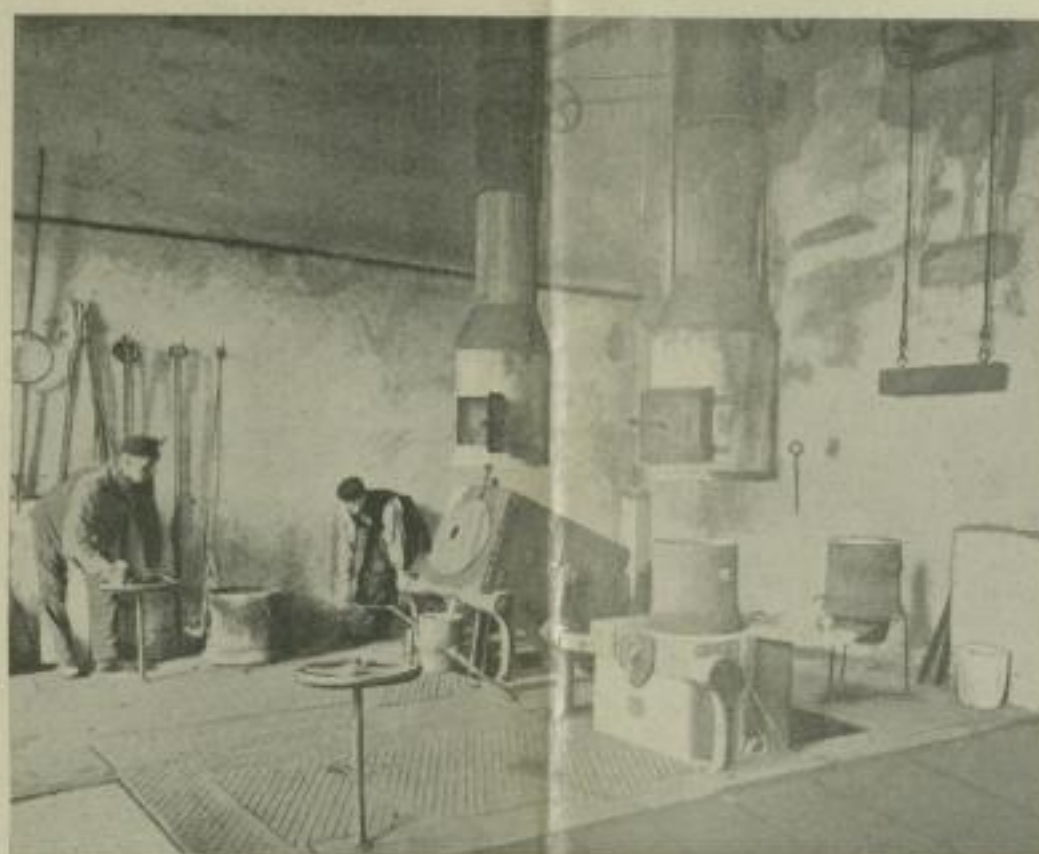
Baumann-Ofen-Anlage zu 2 Ofen à 200 kg. Inhalt.
