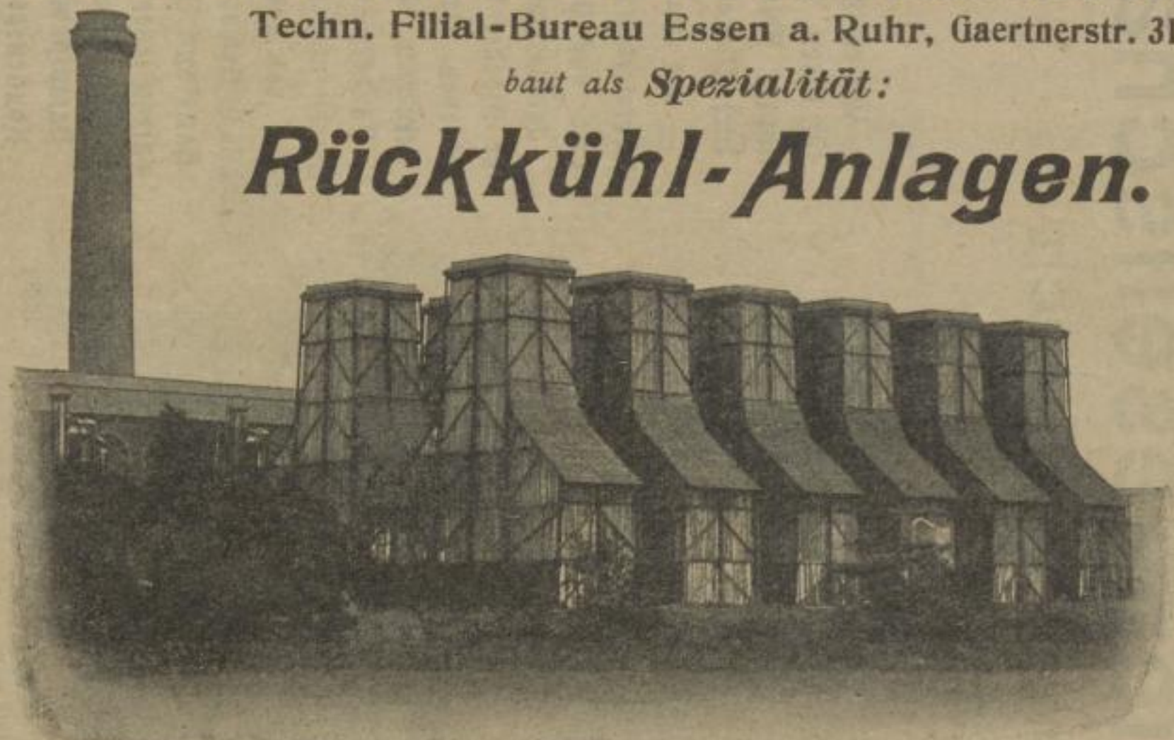
Kühlanlage, ausgeführt für die Elektrische Kraftstation der Metropolitan Railway Co., Neasden b. London. 7000 cbm Wasser pr. Stunde.
