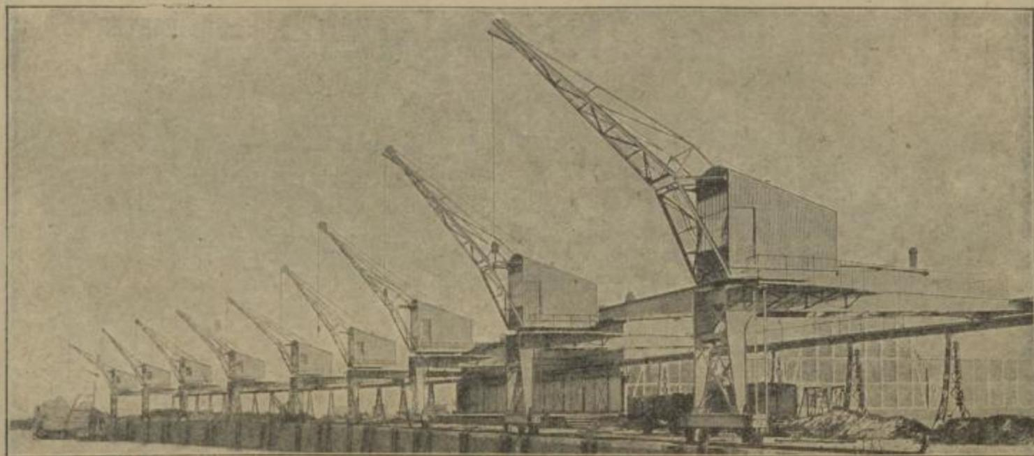
Elektr. betriebene Portal-Drehkrane, geliefert für die Kgl. Wasserbauinspektion Harburg (Elbe).
