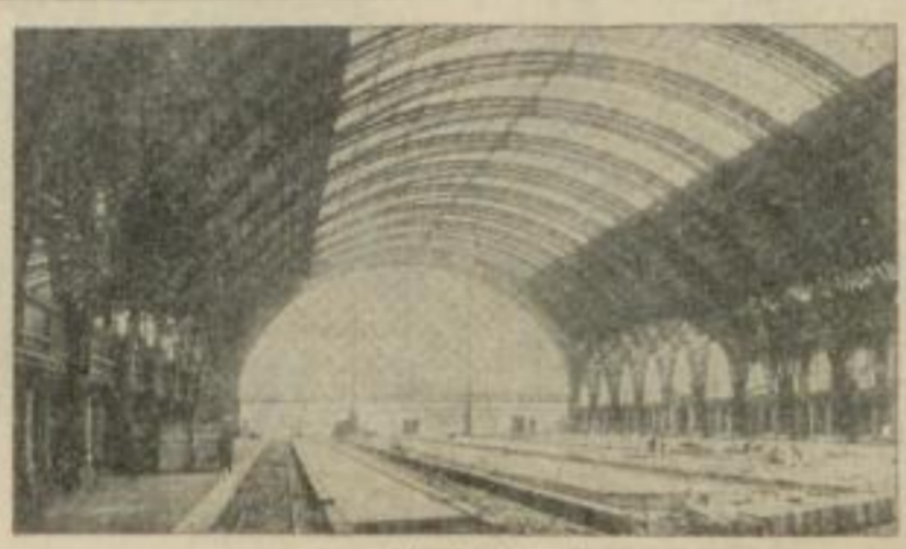
Hauptbahnhof Dresden Spannweite 59 m, Länge 180 m, Scheitelhöhe 30 m, Gewicht 8.700.000 kg
