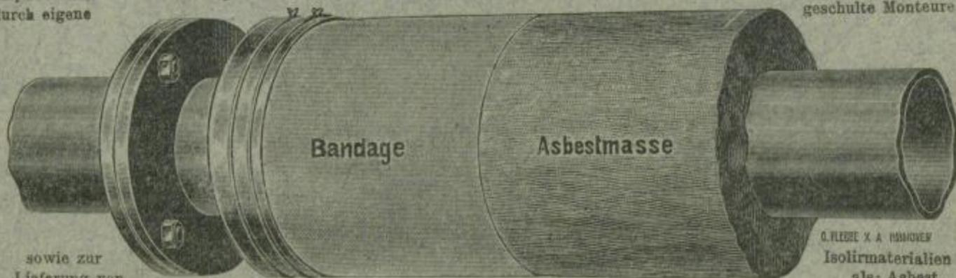
sowie zur Lieferung von Asbestmasse, Asbest-Kieselguhr-Composition etc in hervorragenden Qualitäten zum Selbstisoliren fertig zum Gebrauch.
