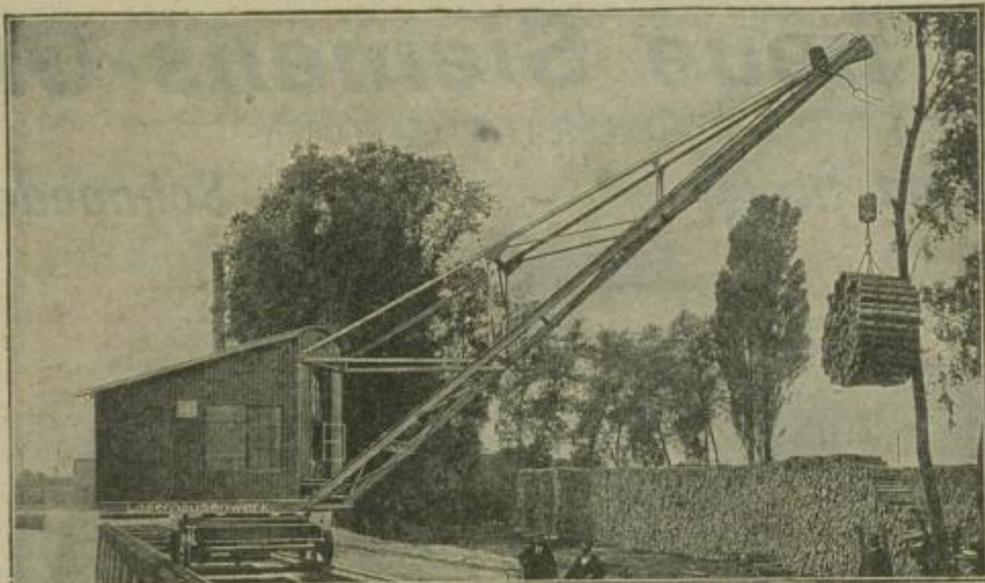
Fahrbarer, elektr. Uferdrehkran, 2000 kg Tragkraft, 11,5 m Ausladung.
