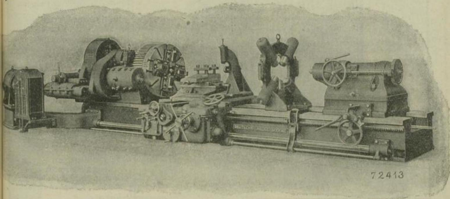
Schwere Schrupp-Schnell-Drehbank mit 600 mm Spitzenhöhe
