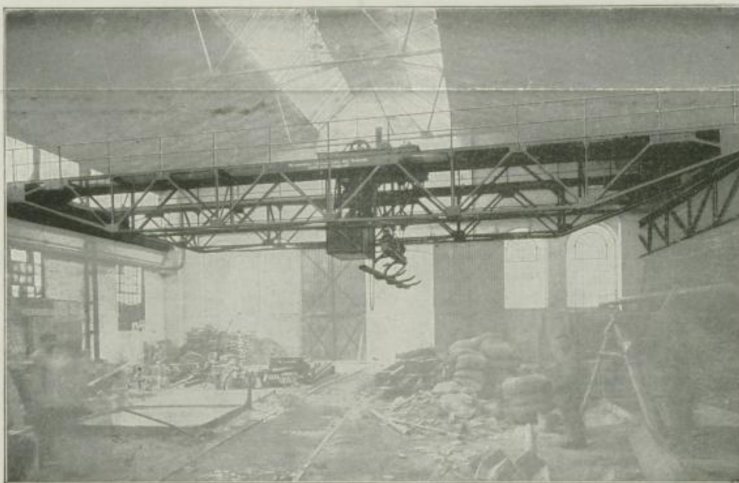
Prattenkran von 20,5 Meter Spannweite
