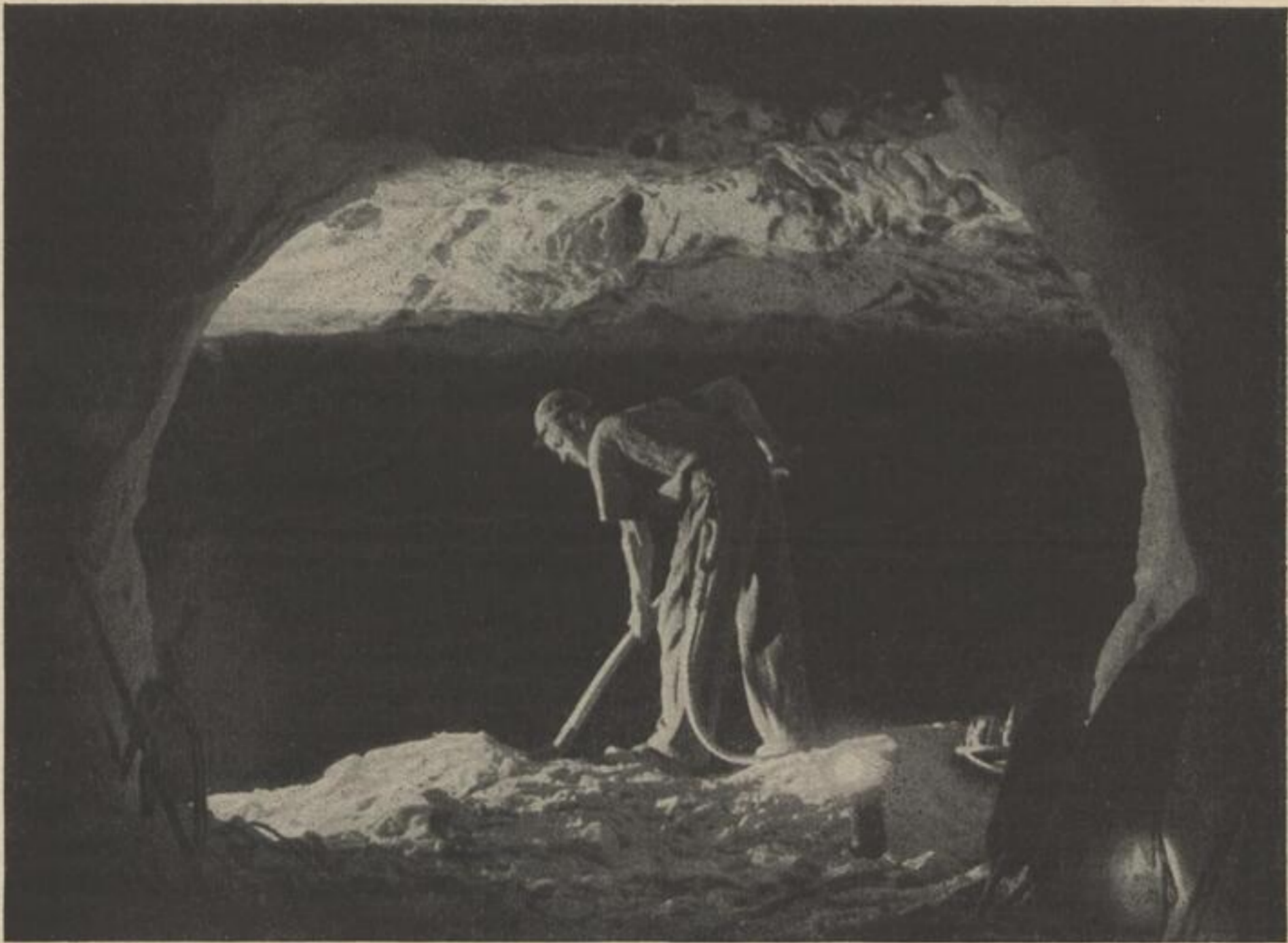
Bild 224. Vierhundert Meter unter Tage. Blick in ein Staßfurter Salzbergwerk. Die gut gewählte Ausleuchtung läßt den Kumpel klar im Raum stehen. Die Schattenpartien werden durch das Bergmannsgeleucht im Vordergrund aufgehellt. Gute Halbtondurchzeichnung gibt den Übergang zu den Tiefen der Abbauräume. Wilhelm Biscou, Großottersleben; Exakta Varex; Tessar 2,8/50; Blende 5,6; \frac{1}{2} s
