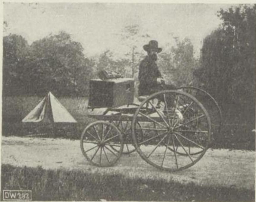
Bild 16. Fahrrad für Photographen, 1874
