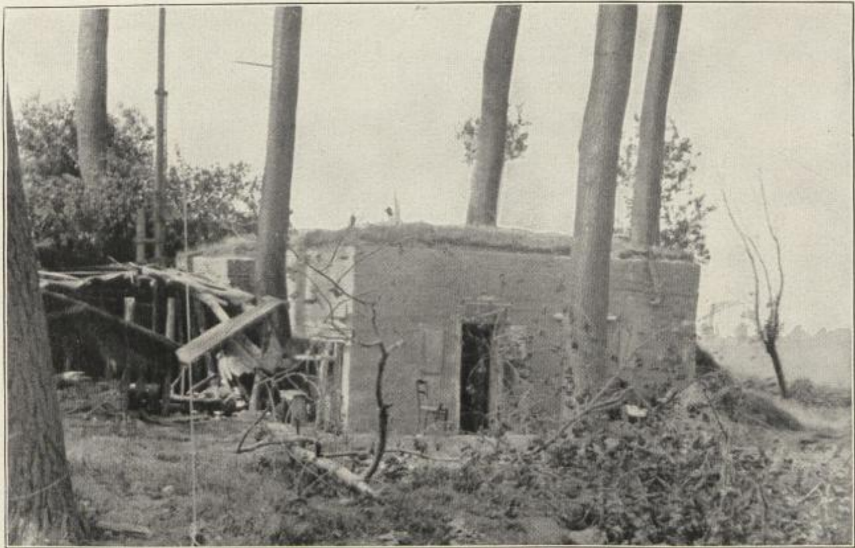
Der erste Betonunterstand in Flandern.
