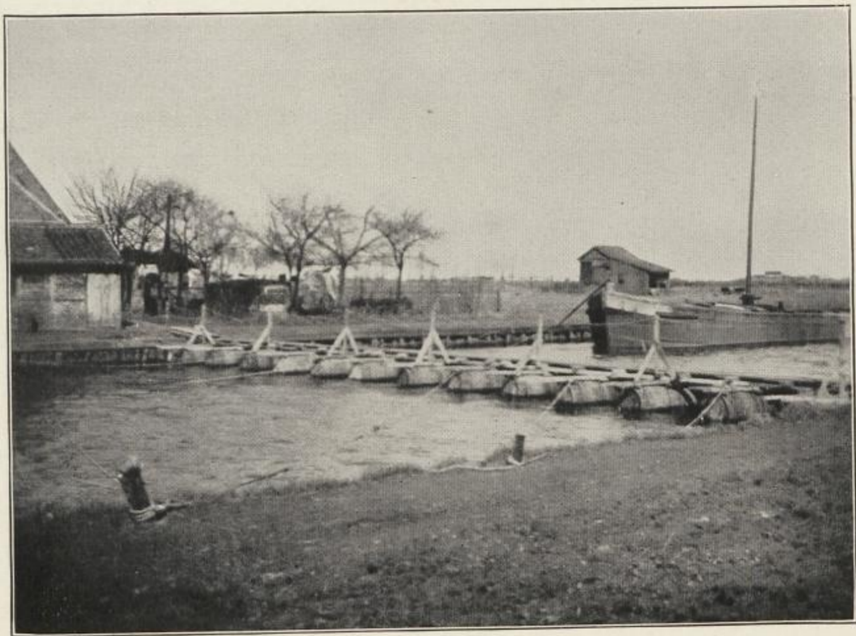
Brückensteg über die Deüle.
