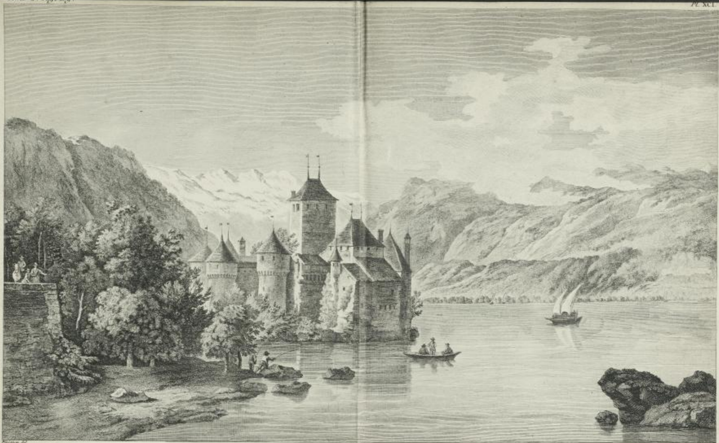
II e VUE DU CHATEAU DE CHILLON Dans le Canton de Berne, sur le Lac de Genève, prise du côté du Vallais. Voyez les Nos 1. & 17.
