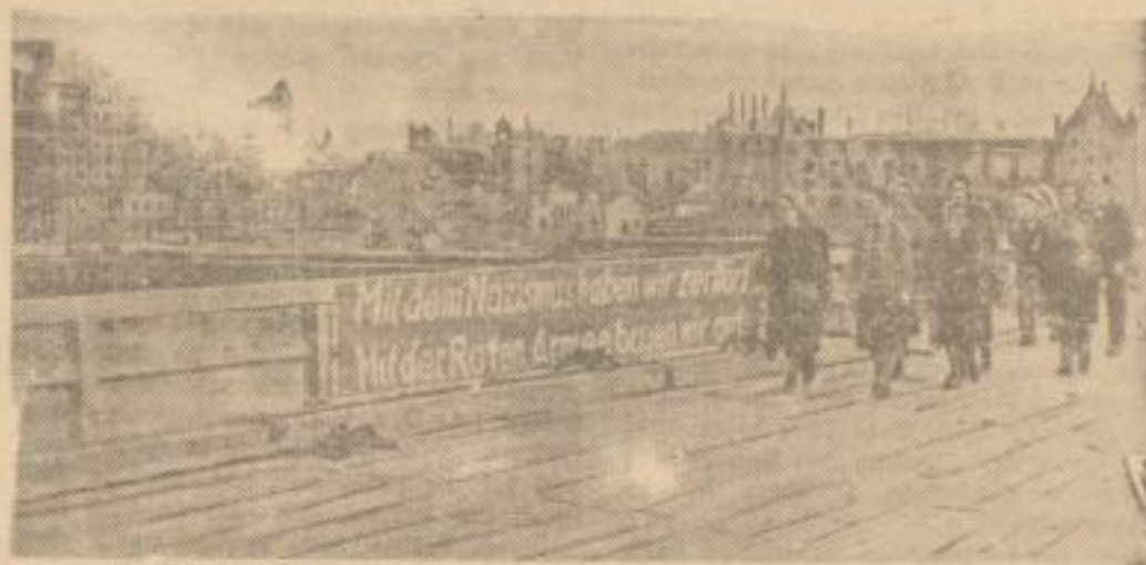
Dresden — Die wiederhergestellte Marienbrücke
