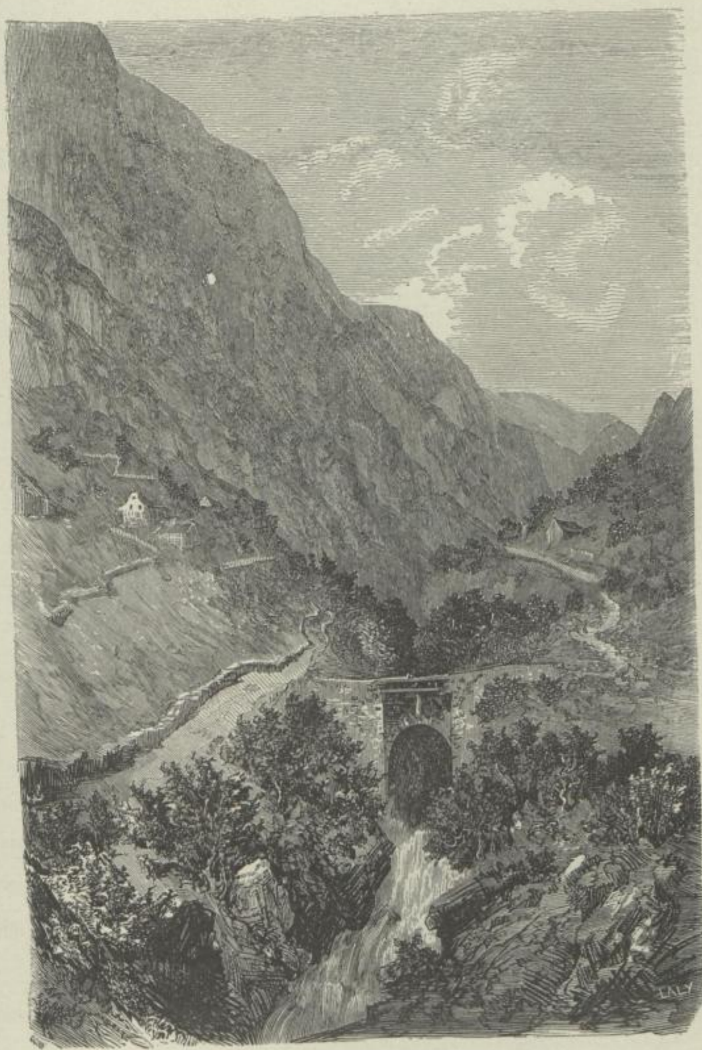
Pont de l'Artigue, à Scia.
