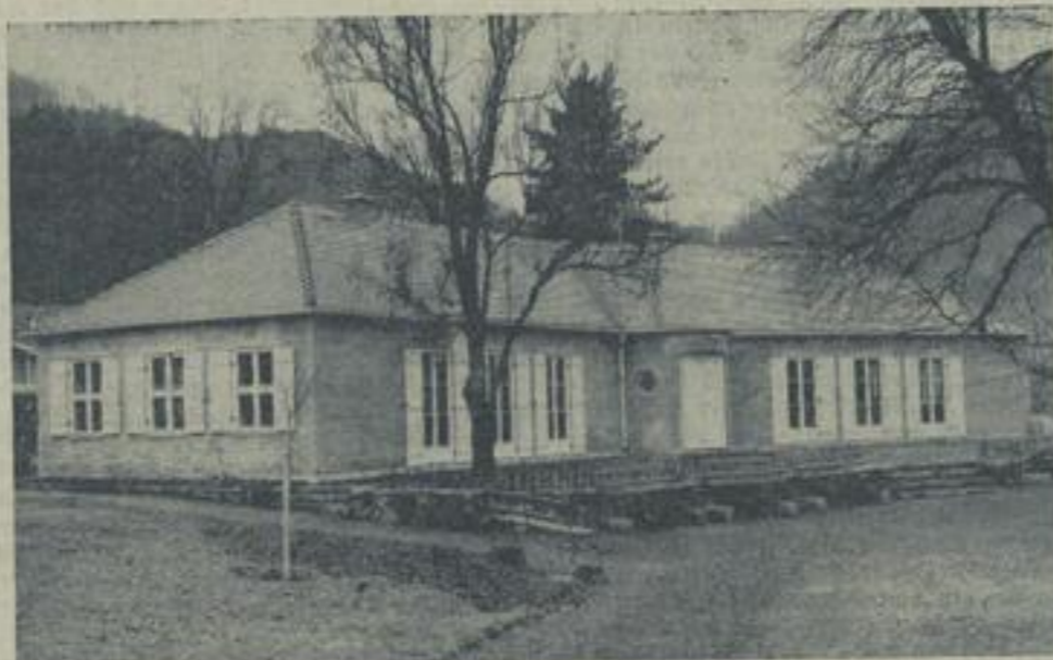
Das Kameradschaftsheim der Spinnerei Cossmannsdorf das nach Entwürfen des Architekten Lehmann-Dresden im Park des Verwaltungsgebäudes gebaut und unlängst eingeweiht wurde.
