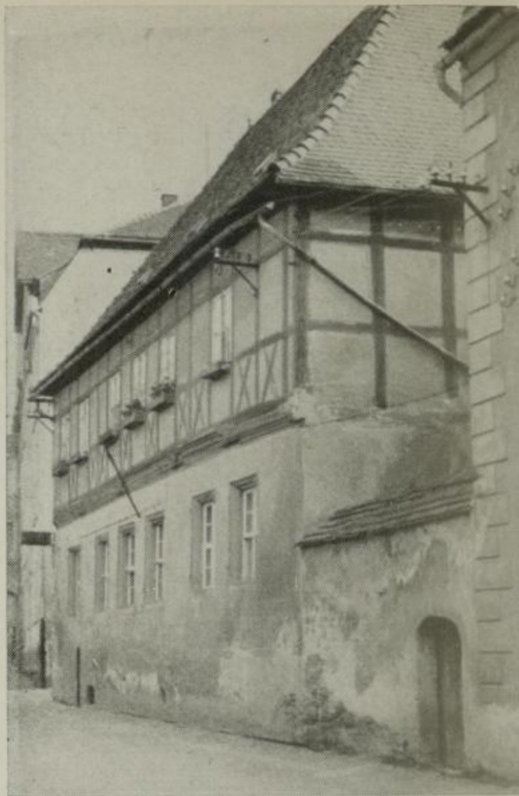
Fachwerkhaus in der Schulgasse, Ecke Topfmarkt; ehemals eine der ersten Textilfabriken Deutschlands
