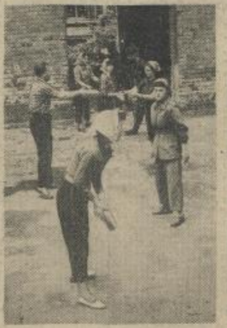
Die Trümmer müssen weg und die Ziegel geborgen werden. Darin waren sich die Studenten vieler Fakultäten und Institute einig, als sie in den letzten Wochen daran gingen, die Trümmerberge in Leipzig zu beseitigen.
