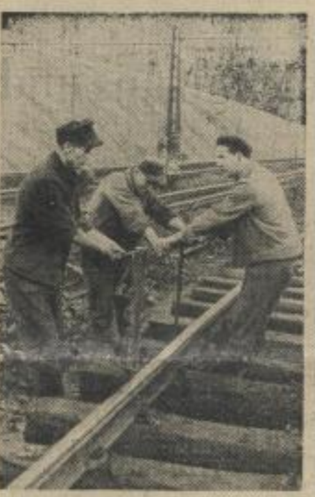
In den meisten Braunkohlenwerken helfen wir im Gleisbau.
