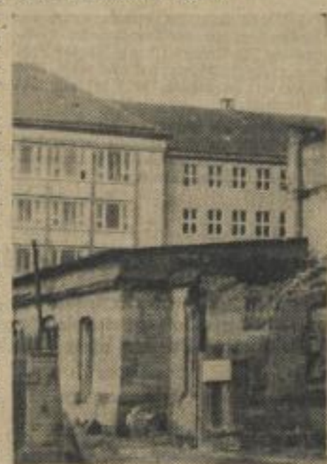
Hinter den Resten des zerstörten alten Instituts wuchs der Neubau
