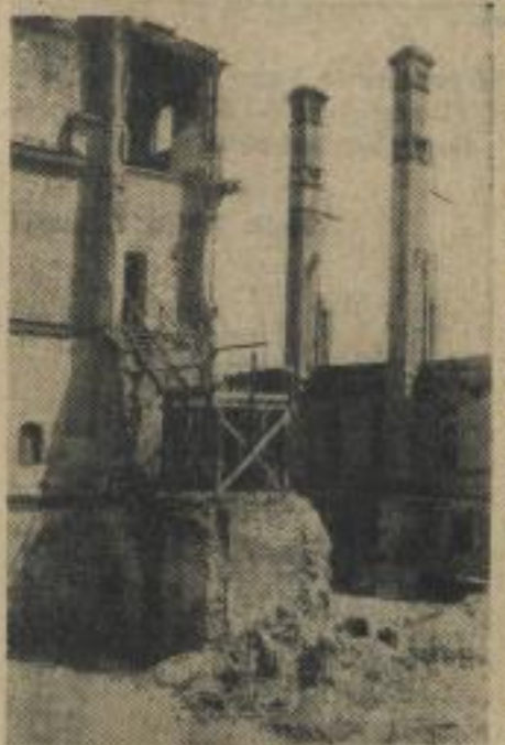
Ruine des alten Instituts — Hinterlassenschaft des Faschismus und amerikanischer Bomben
