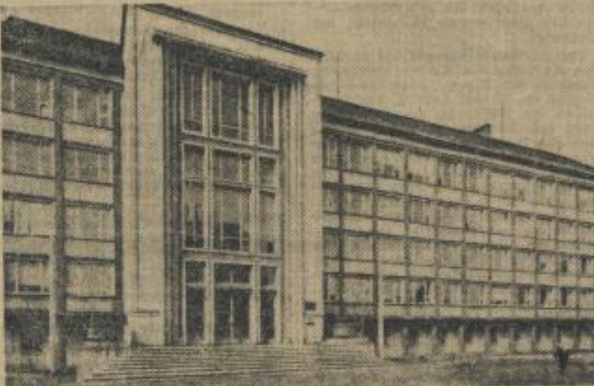
Unter dem Bombenhagel sank am 4. Dezember 1945 der größte Teil der Universität in Trümmer. Dem Fleiß der Werktätigen verdanken wir heute neue, großzügig ausgestattete Institute. Unser Bild zeigt eine Teilansicht des Physikalischen Instituts. Foto HBS
