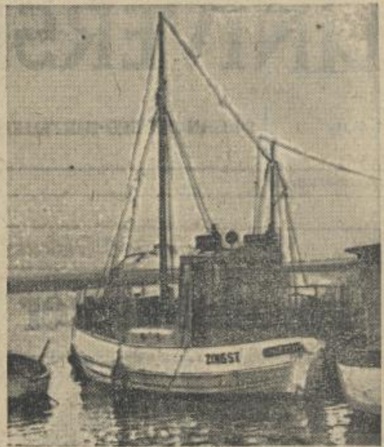
Am 9. 12. 1960 wurde am Maritimen Observatorium der Karl-Marx-Universität in Zingst der Forschungskutter „Atar“ in Dienst gestellt. Die Länge des aus Holz gebauten Fahrzeuges beträgt 12,5 m, seine größte Breite 4 m. Ein 40 PS starker Dieselmotor gibt ihm eine Geschwindigkeit von rund 7 Knoten (13 km/h). Mit diesem Schiff verfügt die Karl-Marx-Universität erstmals über ein seetüchtiges Fahrzeug, das bei den vom Maritimen Observatorium Zingst in den Darsser Boddenengewässern und später in der westlichen Ostsee durchgeführten meereskundlichen Arbeiten eingesetzt wird. Außerdem dient der Kutter zu Ausbildungszwecken während der für Studierende der Geo- und Fischereiwissenschaften in Zingst durchgeführten meereskundlichen Praktika.
