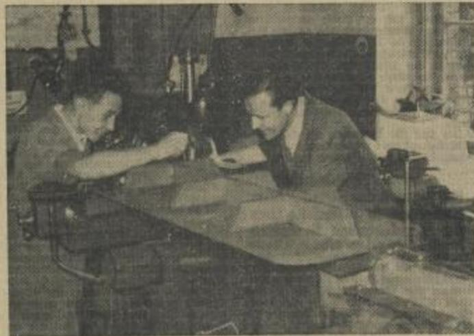
Feinmechanikermeister Ehrhardt (rechts) mit einem Kollegen beim Bau eines Röntgenspektrographen.
