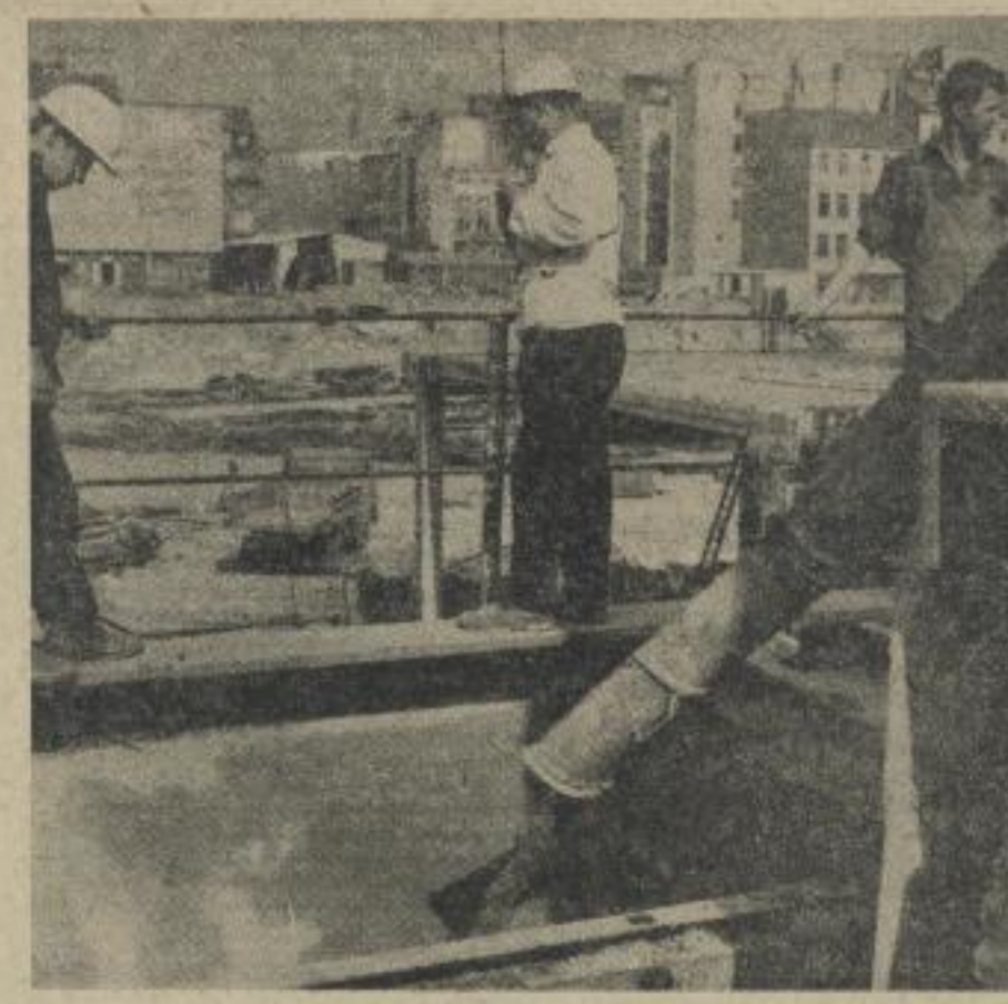
Bild oben: Etwa 5 Kubikmeter, gleich 12 Tonnen Transportbeton, liefert das Fahrzeug in die Vorratsbehälter, von wo aus er per Transportkübel und Turmdrehkran auf Gerüst oder per Pumpe ins Kellergeschoß und dann mit dem Betonpump zu den drei Verteilerris auf dem Gerüst befördert wird. Das ganze Gerüst wandert seit der Arbeitsbühne allmählich aufwärts. Mittlerweile sind die ersten beiden Geschosse frei, allerdings, da sie nur an den Spitzseiten Fenster haben, schwer zu erkennen. – Unten: Betonlieferung. Die Kommandos an den Kranführer werden per Sprechfunk gegeben (Bildmitte).
