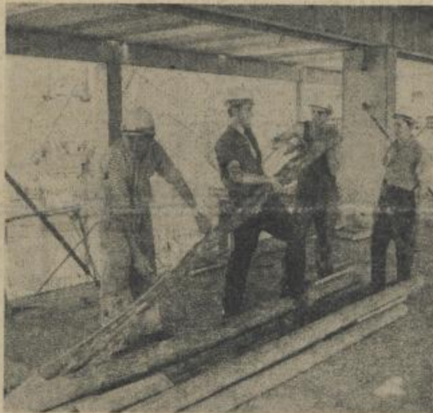
Physikstudenten arbeiten zur Zeit an der Baustelle des Hauptgebäudes des Universitätsneubaus. Die Freunde sind den einzelnen Brigaden der Bauarbeiter zugeweiht und arbeiten in zwei Schichten.
