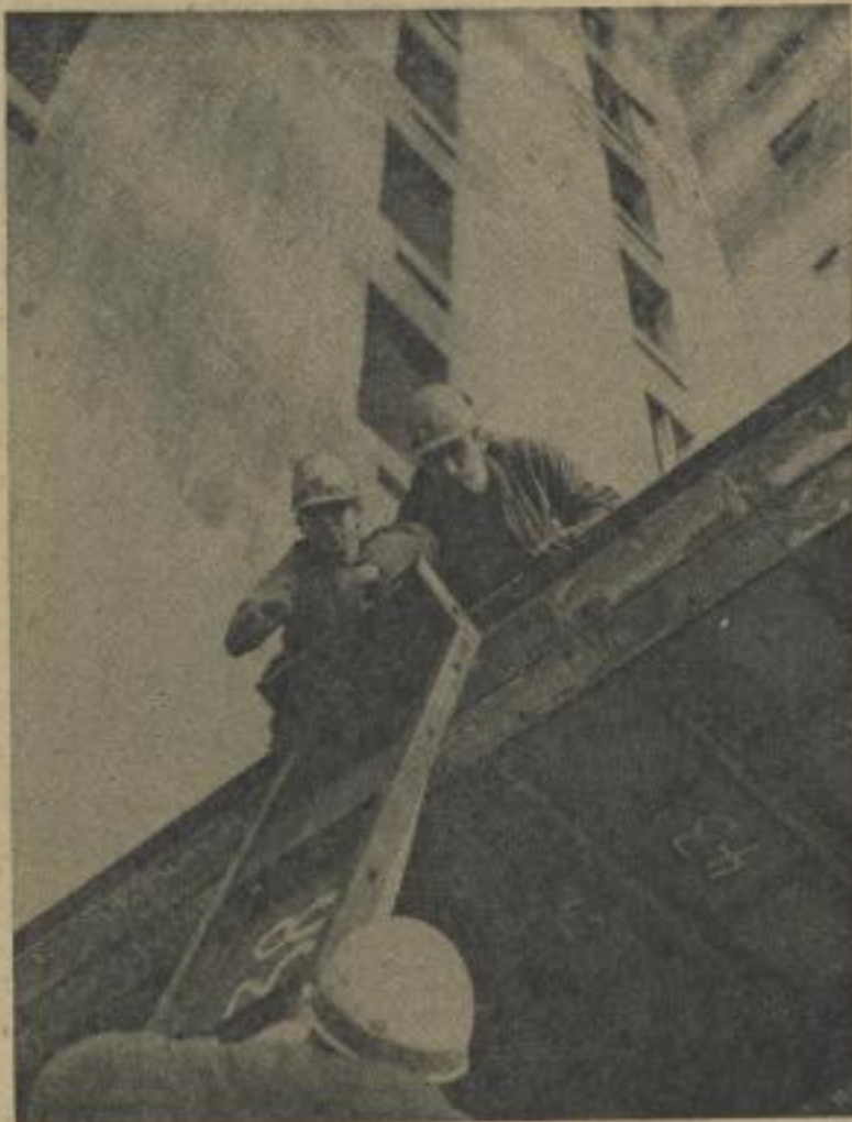
Mitglieder der Brigade „VI. Parteitag“ beim Deckeneinbau.
