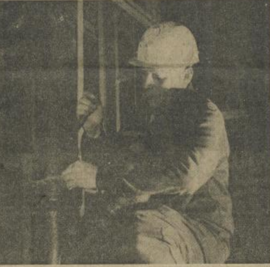
Während die Bauarbeiter die Montage der Stahlspitze am Hochhaus zum Abschluß bringen, machen die Innearbeiten im Hochhaus immer größere Fortschritte. Unser Bild zeigt einen Kollegen vom VED TGA beim Anbringen von Entwässerungsröhren im 5. Obergeschoß. So wie im Hochhaus sind im Hauptgebäude die Mauer- und Putzarbeiten voll im Gange. Neben dem Abdecken des Dachbereiches im Hauptgebäude werden dort wie auch im Hochhaus bereits Telefondrähte gespannt.
