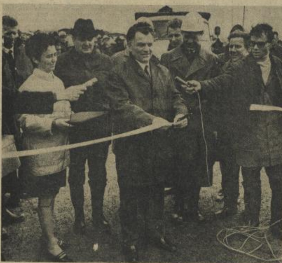
Baubeginn am Bezirksjugendobjekt „Olefin I“ (April 1970)
