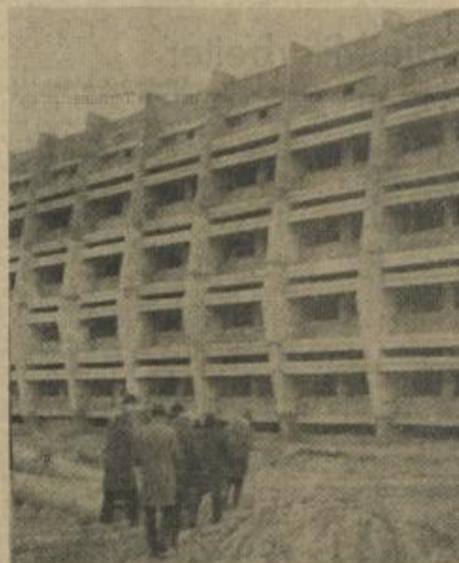
Das erste im Rohbau fertige Gebäude im Neubaukomplex der Schewtschenko-Universität. Dieses Gebäude soll 1973 durch die Metro mit dem Stadtkern verbunden sein.
