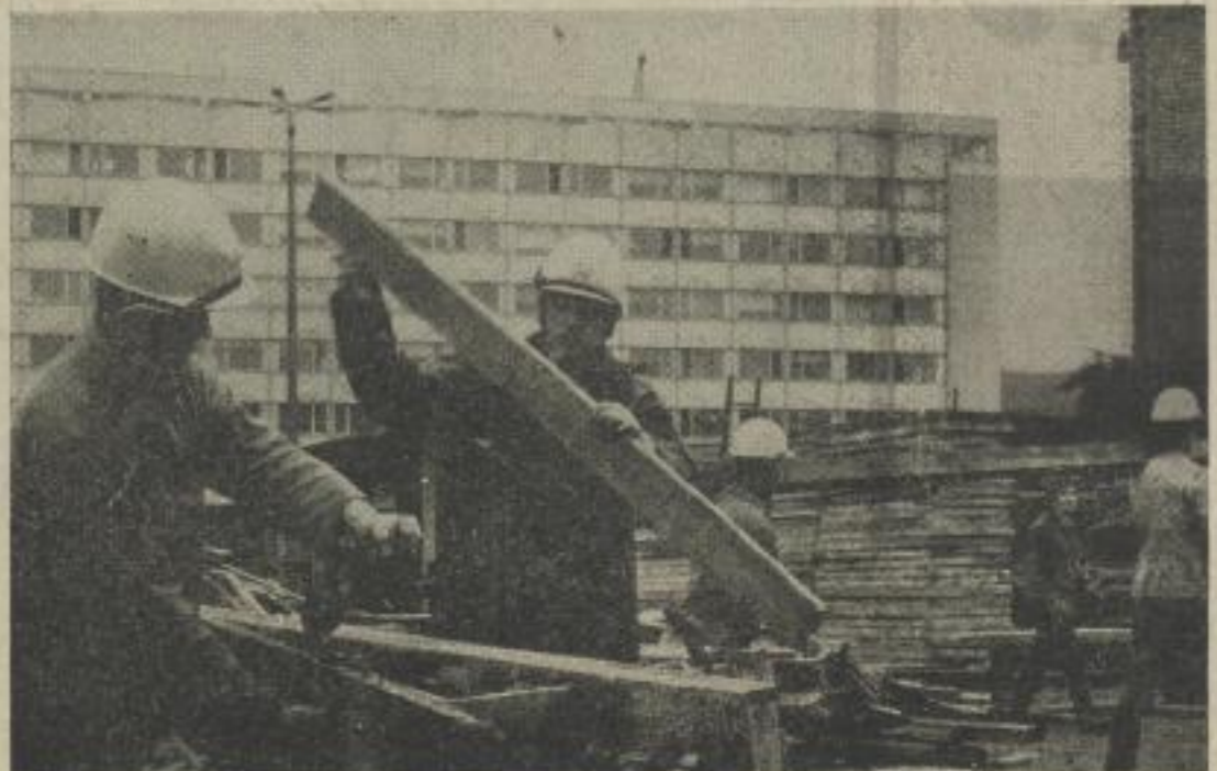
Studenten des 3. Studienjahres der Sektion Politische Ökonomie MLO bei Holzeubereitungsarbeiten auf der Baustelle Unineubau. Für sie reichte der Studentensommer 1971 bis in den Oktober hinein. Foto: Manfred Raschke
