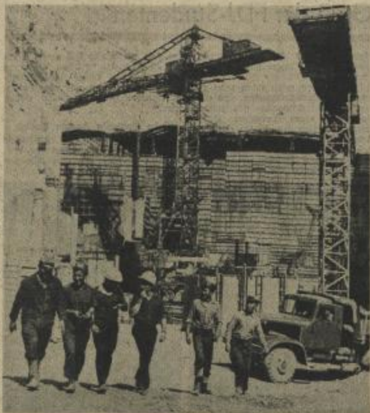
DAS ERSTE DRITTEL IST GESCHAFFT – Täglich verließen die Erbauer des größten mittelasiatischen Wasserkraftwerkes beim Erreichen des Staudamms 2400 Tonnen Beton, 19 Milliarden Kubikmeter Wasser werden sich anstauen, Wasser, das auch zur Irrigation in Kirgisien und Usbekistan dienen wird. Foto: DAS
