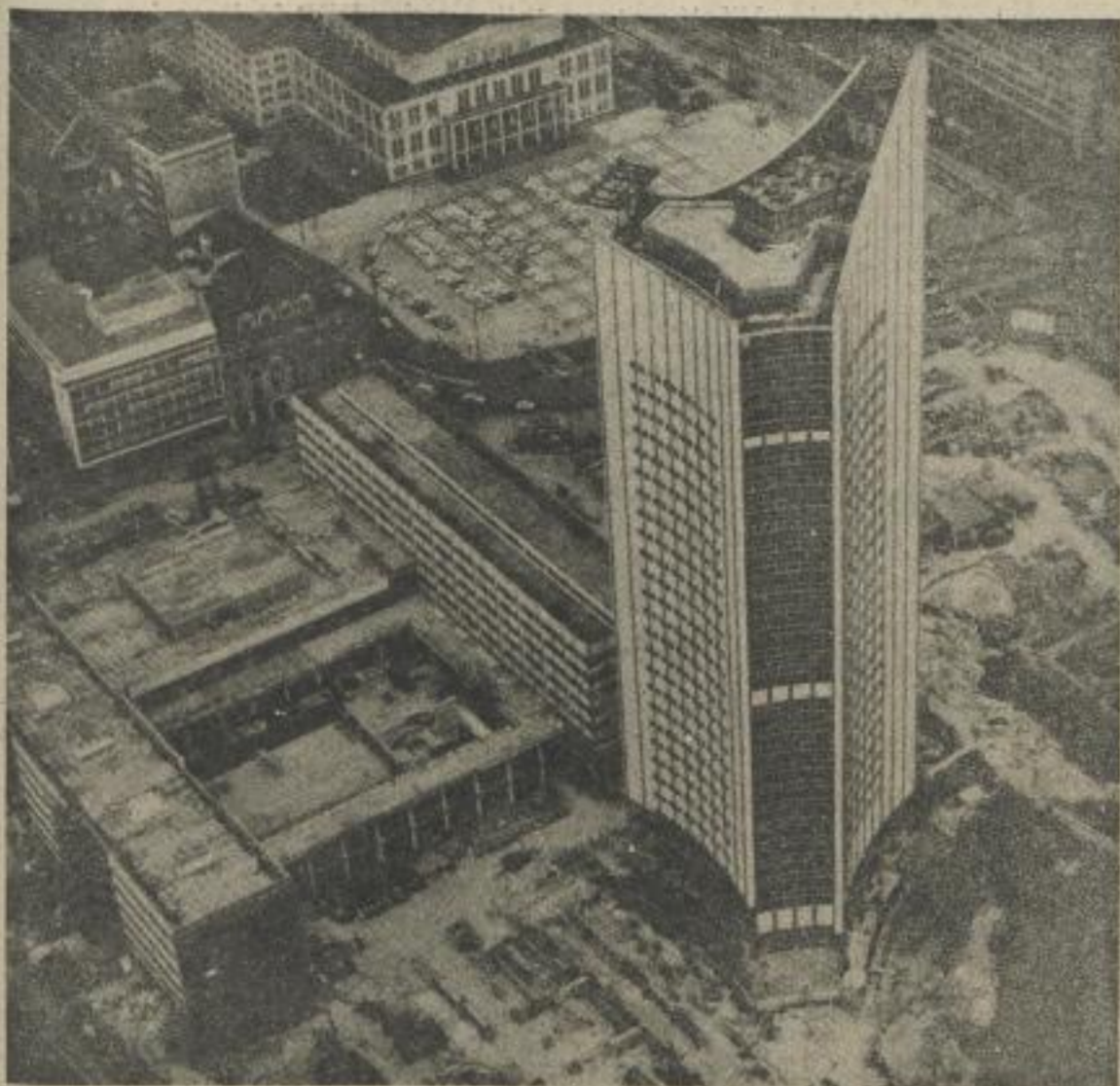
DER NEUE UNIVERSITÄTSKOMPLEX aus der Vogelperspektive (Stand September 1972). Im Vordergrund die Fundamente für den Hörsaalkomplex, in dessen Mitte die Zweigstelle der Universitätsbibliothek untergebracht wird. Links diagonal aus dem Bild herausführend das Seminargebäude. Daneben der Innenhof und nach hinten anschließend die Mensa. Das helle Dreieck auf der Hochhausspitze ist die Aussichtsplattform. Rechts daneben und darüber noch vier Etagen mit spezieller Technik (Wir werden über das Hochhaus noch ausführlich informieren).
