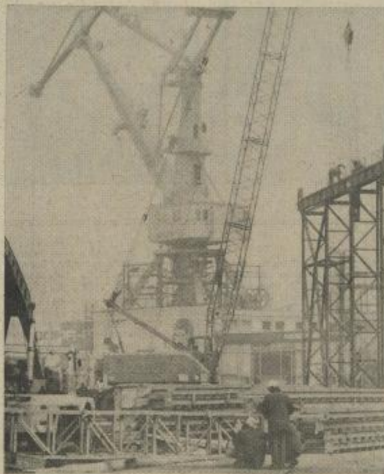
MESSEVORBEREITUNG: Einem großen Bauplatz gleicht zur Zeit das Freigelände des Industriezweiges TAKRAF auf dem Leipziger Messegelände. 200 Ausstellungsstände, darunter viele Neu- und Weiterentwicklungen, legen Zeugnis von der Leistungsfähigkeit der Kollektive dieses Wirtschaftszweiges ab.
