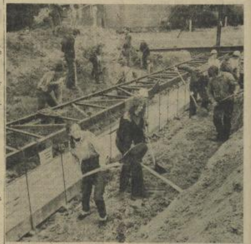
DIE STUDENTEN Ekuadors rufen zu einem Arbeitseinsatz auf. 70 Studenten verschiedener Sektionen der Karl-Marx-Universität waren am Sonntag auf der Wohnbaustelle Schönfeld erschienen und begannen mit Erschließungsarbeiten für Versorgungsleitungen. Vom Reinerlös dieses Einsatzes sowie vorhergehender und weiterer Einsätze soll eine Druckereimaschine im Wert von 30.000 M gekauft und am Jubiläumstag der Kommunistischen Partei Ekuadors übergeben werden.
