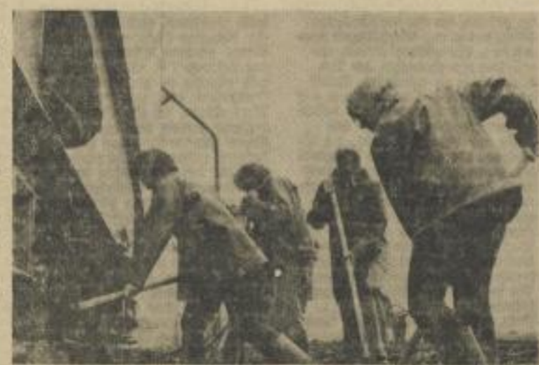
Für Rechtswissenschaftler nichts Neues mehr: mit Schaufeln und Spaten im Arbeitseinsatz.
