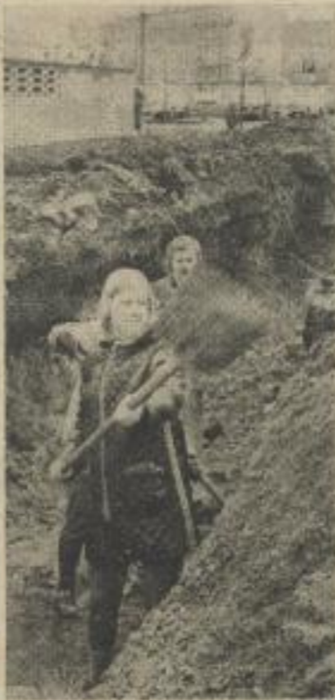
Studenten der Karl-Marx-Universität und der Handelshochschule helfen beim Bau einer Kabeltrasse im Bereich Johannisploß Dörrienstraße. Der Graben wird Kabel für das neue Bahnstromunterwerk Querstraße aufnehmen und damit den Einsatz weiterer Tatra-Großzüge ermöglichen.
