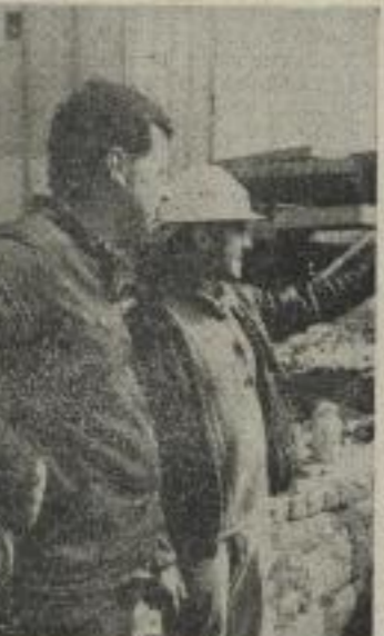
Anfang Juli wurde von Kollegen des VEB Bohrlochzementierung Tomtern eine Zementmischung in die Löcher unter der Basteimauer gepumpt, so daß der Ausbau der oberen Etagen der Bastei nun wieder planmäßig fortgesetzt werden kann.
