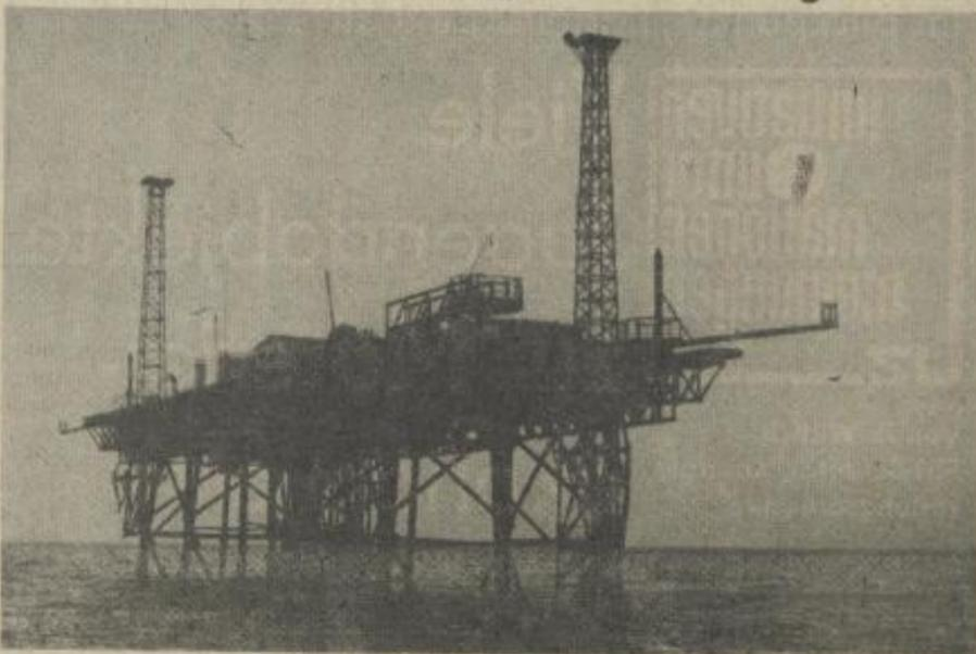
Die Meßplattform im Kaspischen Meer mit 40 Meter Wassertiefe und einer Uferentfernung von 25 km. Foto: Sektion Physik
