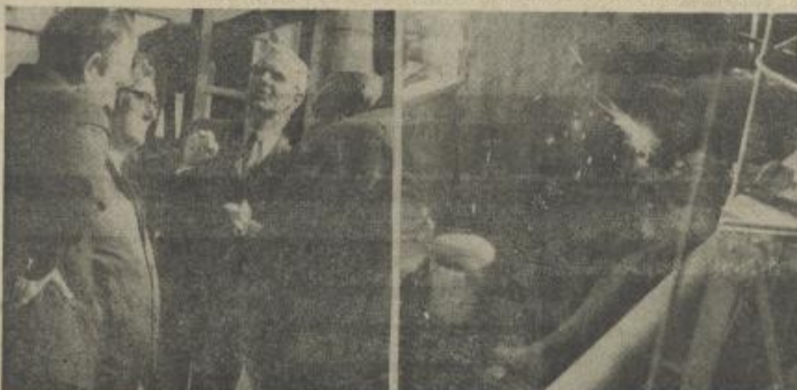
Prof. Dr. Horst Stein im Gespräch mit Vertretern der Bauabteilung der KMU. Foto rechts: Schweißarbeiten im Kesselhaus des Bereiches. Foto: UZ/Wallier
